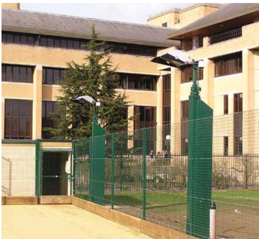
Aby bylo vyhověno požadavkům stavebního úřadu, Oxfordská universita nechala instalovat na svá víceúčelová hřiště 12 teleskopických stožárů. Vytažené mají výšku 8 m, zatažené pak jen 3,5 m.
